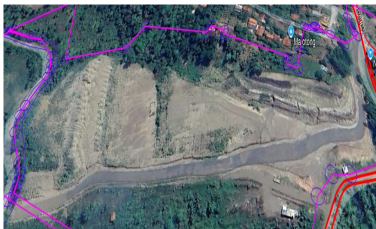
Gambar 1. Kondisi lokasi Proyek Sumedang Industrial Polis Sumber: PT Sukses Perdana Andalan (2026).
