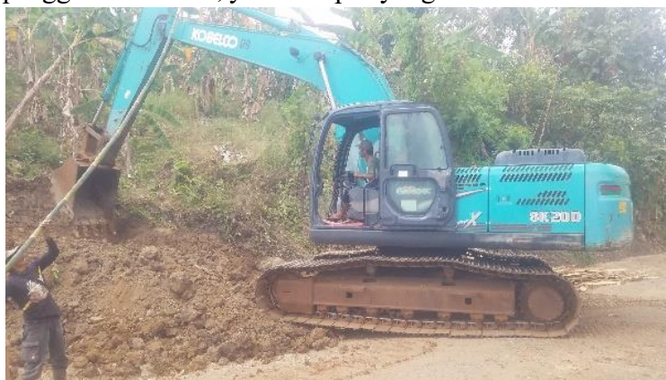
Gambar 2. Excavator pada pekerjaan galian di lokasi proyek
